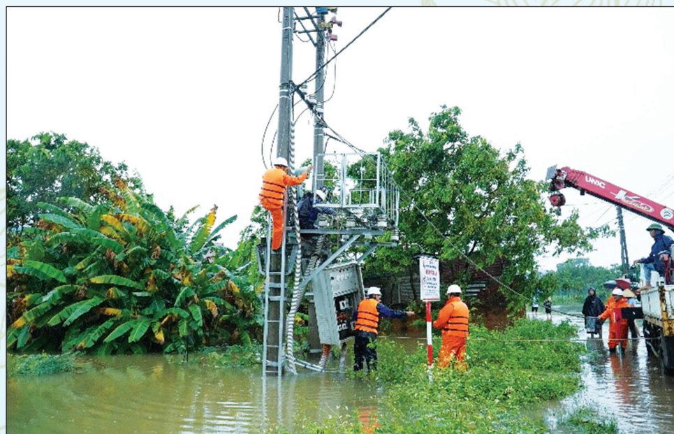
Lực lượng công nhân bám trụ hiện trường, khôi phục cấp điện nhanh chóng sau mưa lũ.
