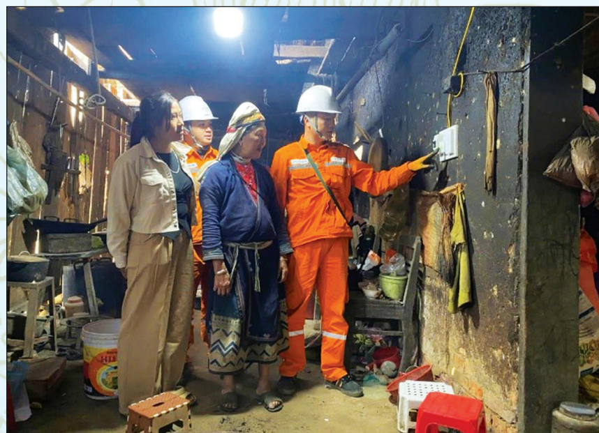
Công ty Điện lực Thái Nguyên sửa chữa, lắp đặt điện miễn phí cho hộ gia đình có hoàn cảnh khó khăn.
