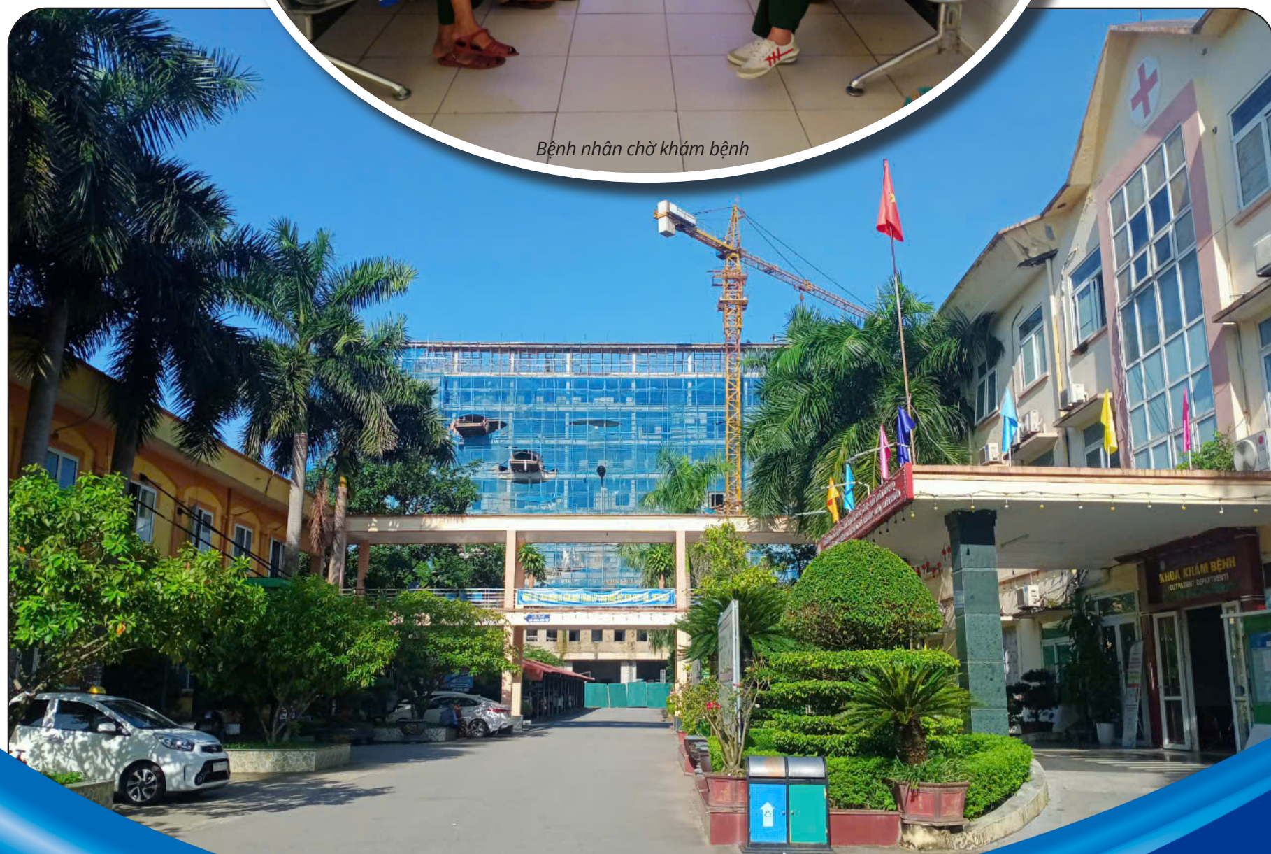
Khu nhà khám bệnh 9 tầng
