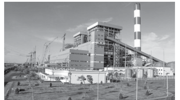
Nhà máy Nhiệt điện Ô Môn I trong Trung tâm Điện lực Ô Môn - nơi sẽ có Nhà máy Nhiệt điện Ô Môn II, III và IV được xây dựng
