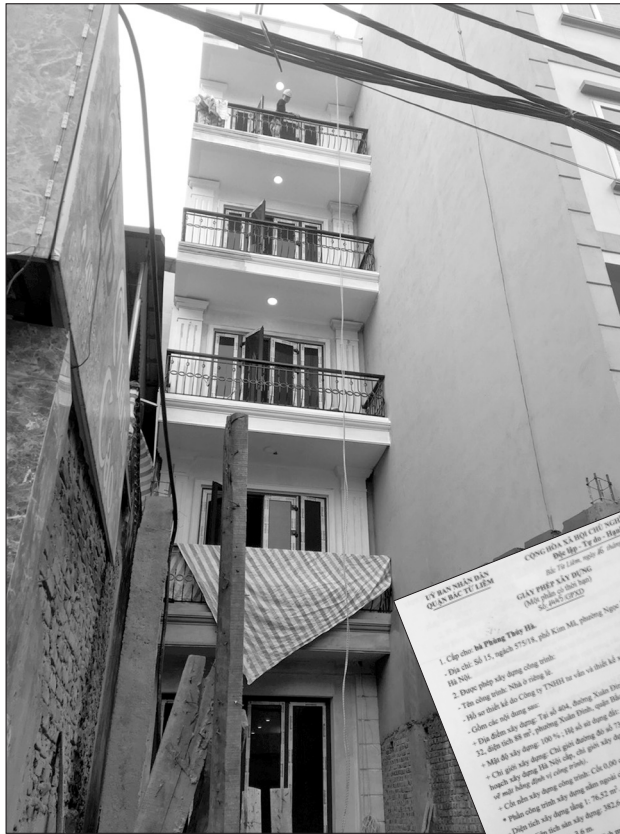
Ngôi nhà 404 được xây dựng sai phép.
