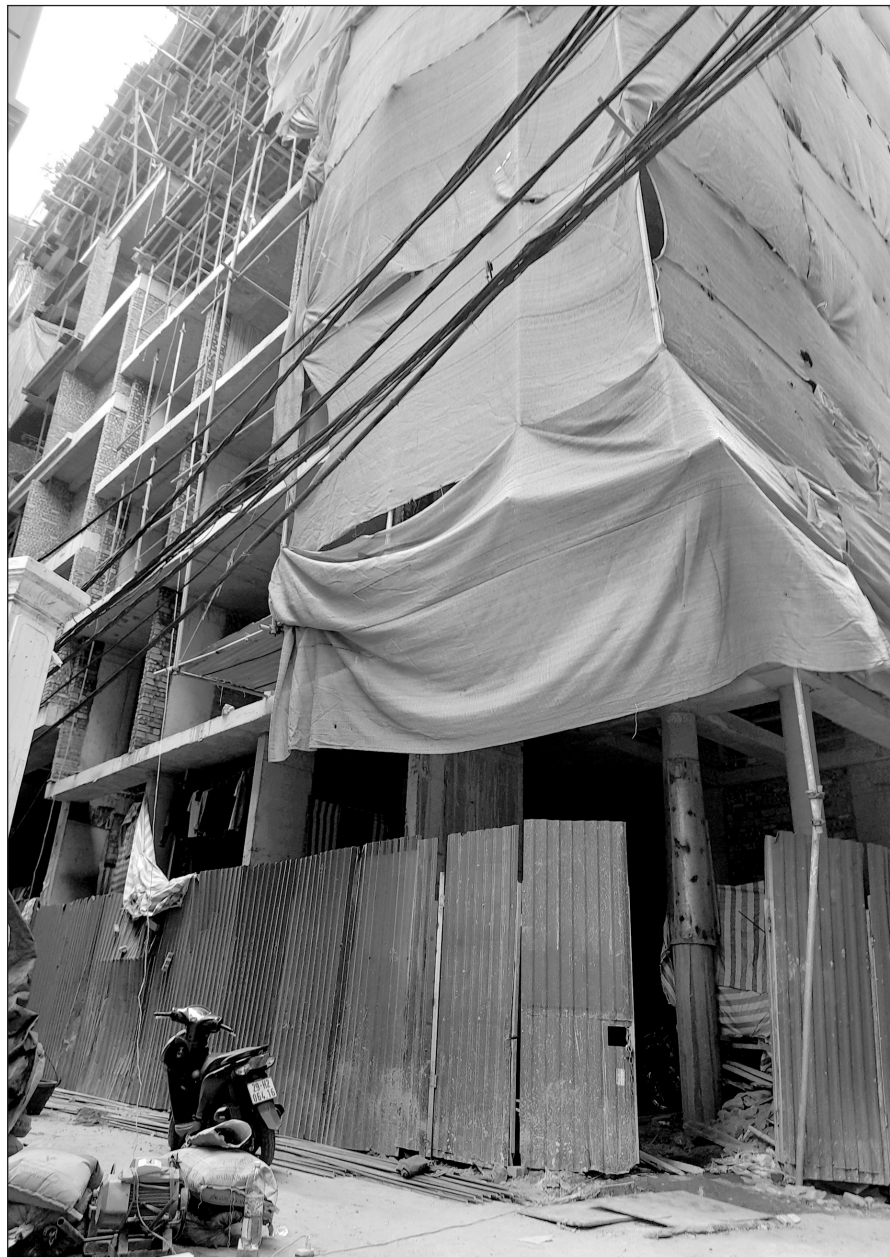
Công trình nhà số 8 ngõ 535 Kim Mã đang được xây dựng, cải tạo lên đến 9 tầng nổi, 1 tầng hầm.
