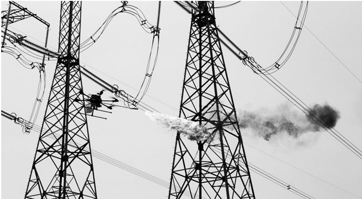
Vật thể lạ vướng vào cột điện đang được UAV tự chế xử lý. Ảnh ĐVCC
