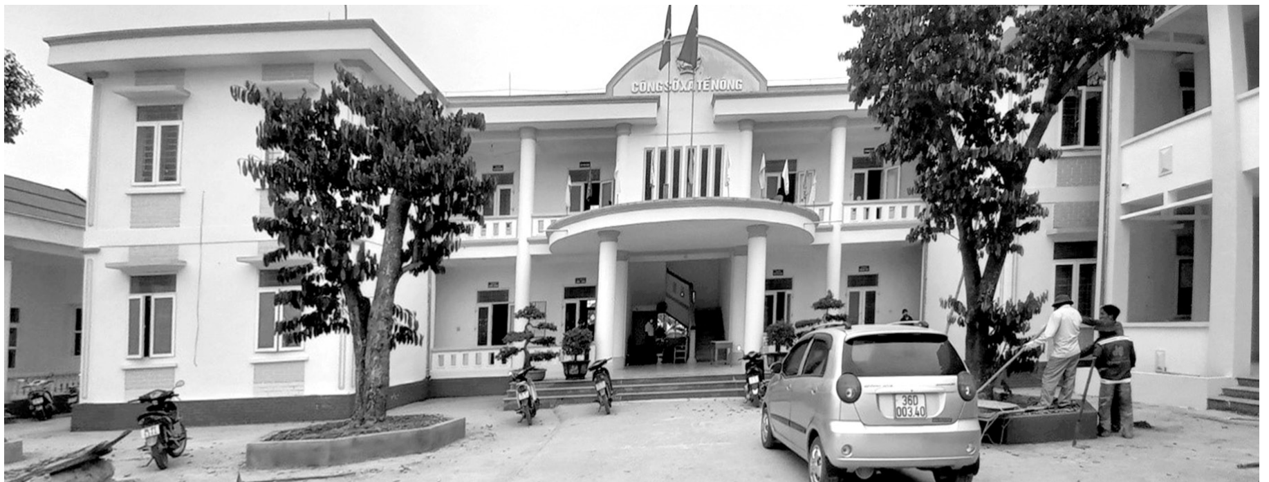
Công sở xã Tế Nông đang được cải tạo và nâng cấp.
