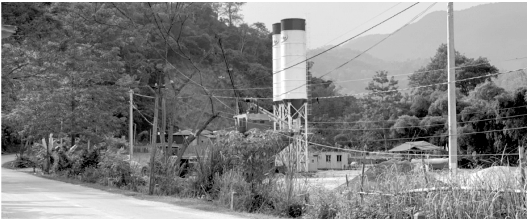
Trạm trộn bê tông thương phẩm của Công ty CP Bút Sơn HP tại xã Thượng Giáo.
